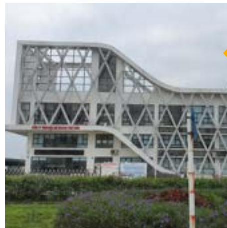
NHÀ MÁY WOLONG
